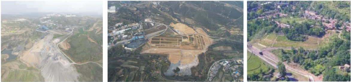
铜川市印台区废弃煤矿矸石山地质环境治理和生态修复项目 收到良好的经济效益、生态效益和社会效益
